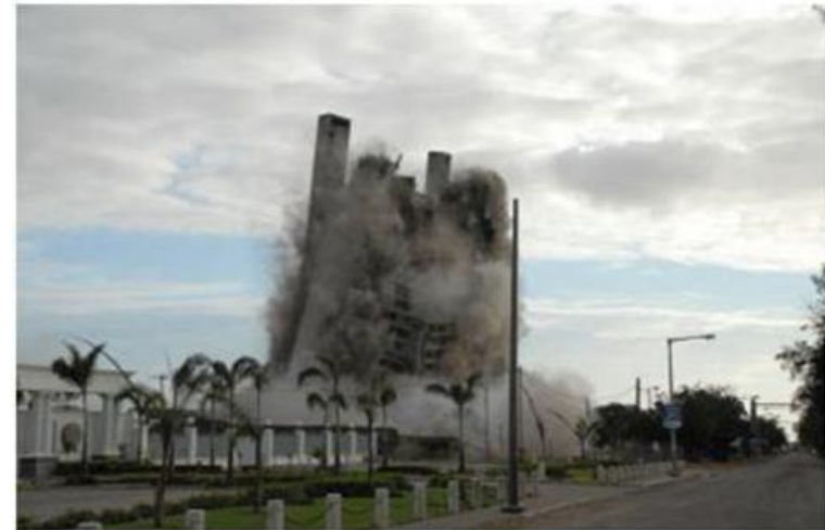
Implosão do "4 Estações", Maputo 2007
