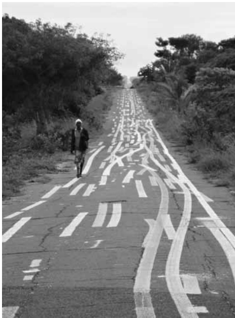
Figura 1: A 'secção de teste' onde os trabalhadores chineses aperfeiçoaram as suas competências de pintura
