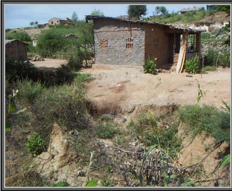
**Figura 1: Casa exposta à erosão pluvial e eólica**
