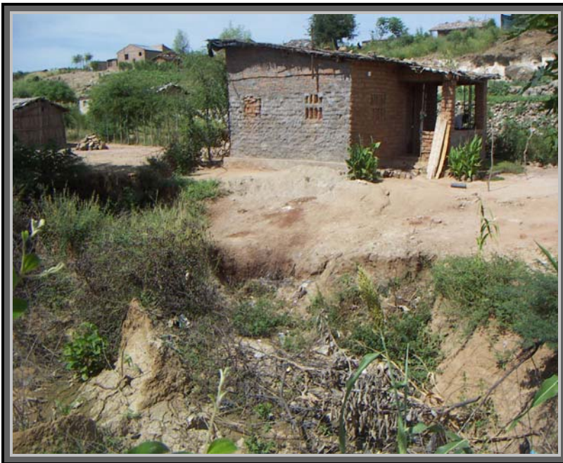
Figura 1: Casa exposta à erosão pluvial e eólica
